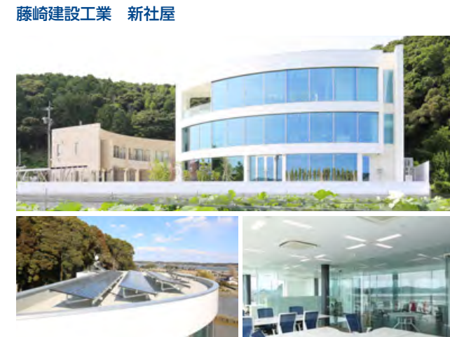
上：新社屋外観／左下：太陽光発電+蓄電池／右下：照明制御システム「FIT LC」
