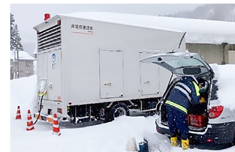
災害復旧の様子
