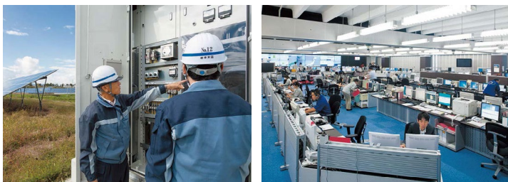
太陽光発電所における定期メンテナンスの様子 24時間365日、太陽光発電所をリアルタイム監視するFOC
