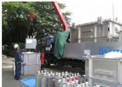
PCB含有機器の無害化処理に向けた搬出作業
