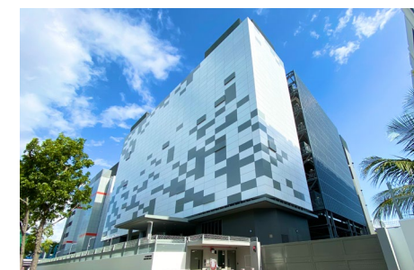
シンガポールでの転換型データセンターの建設例
