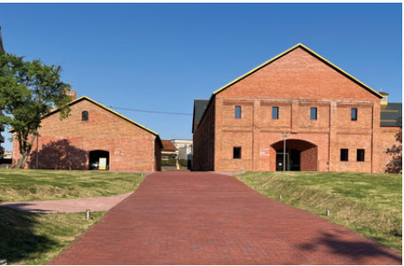
弘前れんが倉庫美術館外観
