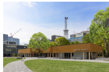
全景(広島県産スギ材を用いた外壁ルーバー)
